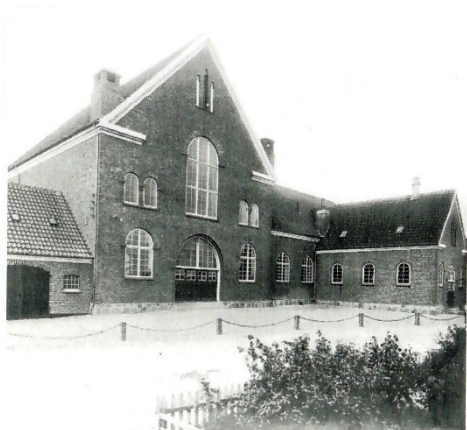
Falsters Højspændingsværks facade mod Kirkevej.
